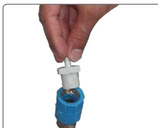
**8**-Aplique fita veda rosca no conector para água e instale-o no ponto de abastecimento de água.
